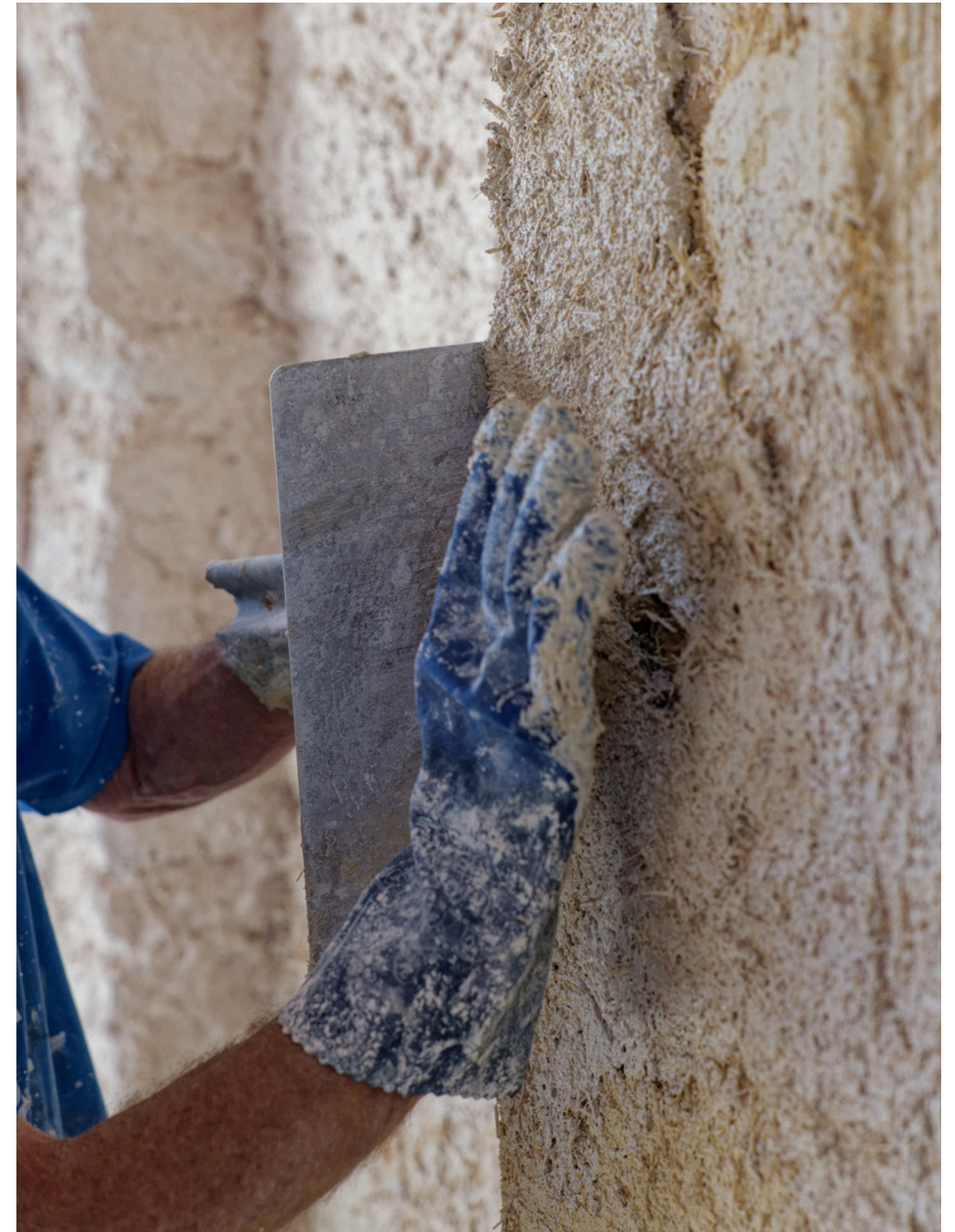
Στιγμιότυπο από τις εργασίες του προγράμματος ΚΕΡΕΤΣΙ Μαθητεία και Εργαστήριο για τα Κονιάματα στην Παραδοσιακή και Αειφόρο Δόμηση. Φωτ. Ιάσοντας Αθανασιάδης
