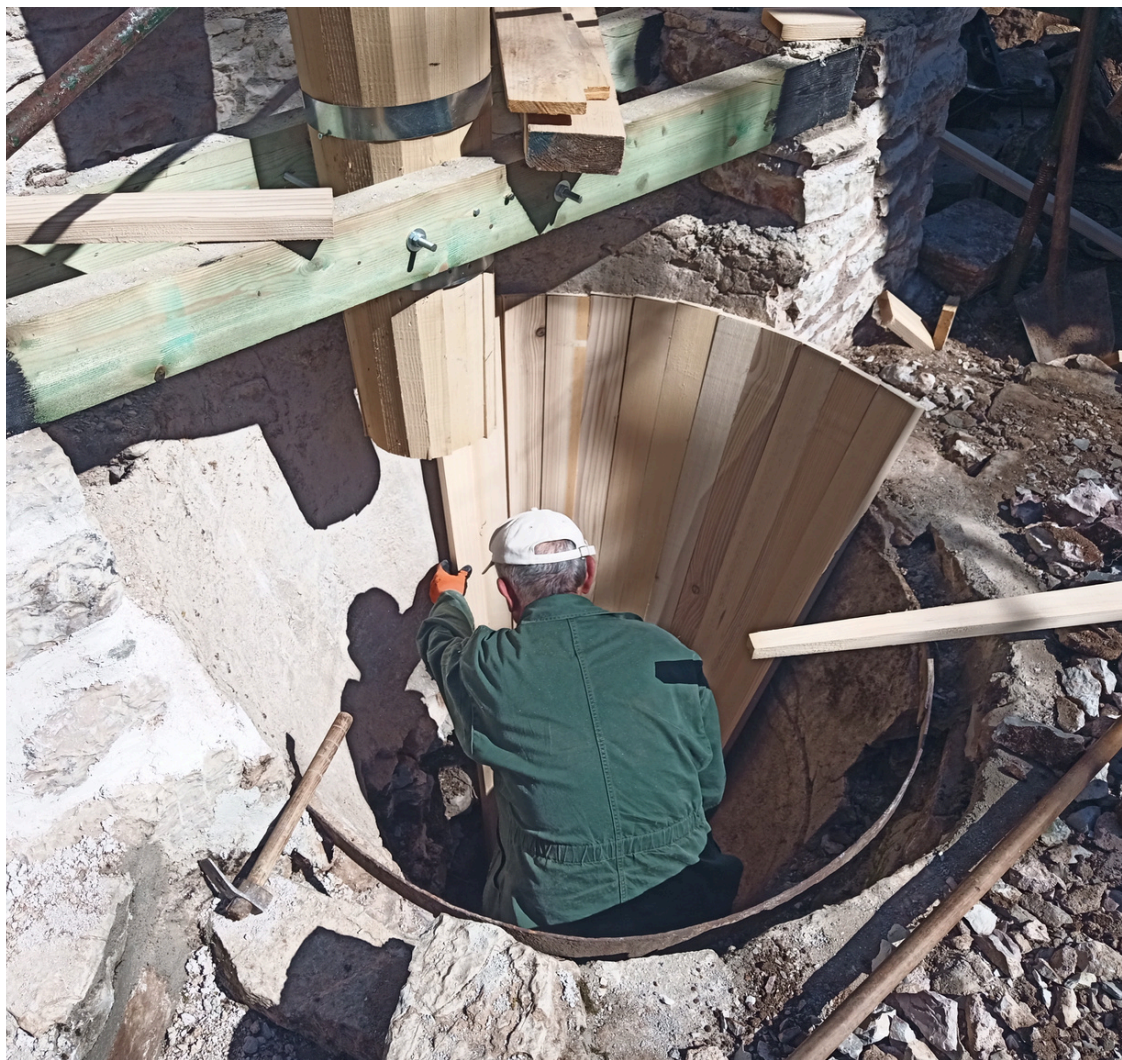
Στιγμιότυπο από τις εργασίες αποκάστασης της νεροτριβής της Μονής Πορετσού. Φωτ. Γρηγόρης Κουτρόπουλος
