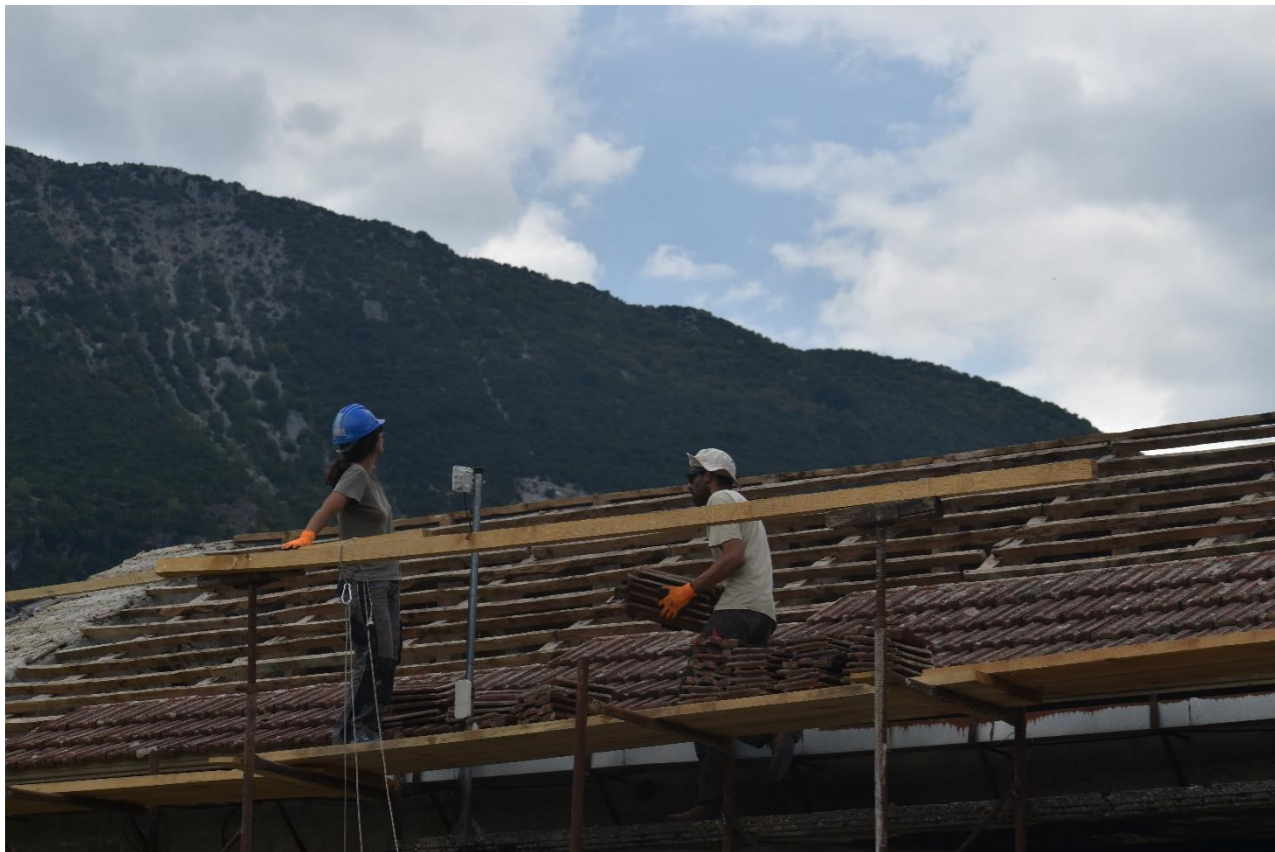
Εικ. 6: Αφαίρεση κεραμιδιών (Χ. Λιόγκας) Εικ. 7: Στίβες με ακέραια κεραμίδια προς επανάχρηση (Ι. Ντούτση) Εικ. 8: Καθαρισμός περιμετρικού σενάζ (Β. Χήτα) Εικ. 9: Αφαίρεση κεραμιδιών και στοιβαγμα στη σκαλωσιά (Χ. Λιόγκας) Απέναντι : Κατέβασμα κεραμιδιών με τροχαλία (Ι. Αθανασιάδης)
