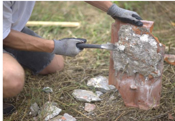
Εικ.6: Μετακίνηση παλιού ελκυστήρα ζευκτού (Ι.Αθανασιάδης)
