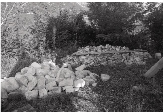
Εικ.4: Η αίθουσα διδασκαλίας χωρίς ψευδοροφή – σημάδεμα στάθμης. (Β. Χήτα) Εικ.5: Καθαίρεση άνω τμήματος τοιχοποιίας (Α. Σιαφάκα) Εικ. 6: Οργάνωση δομικών υλικών που αφαιρέθηκαν (Ι. Ντούτση) ΑΠΈΝΑΝΤΙ: Αφαίρεση κεραμιδιών μικρής στέγης (Ι. Αθανασιάδης)
