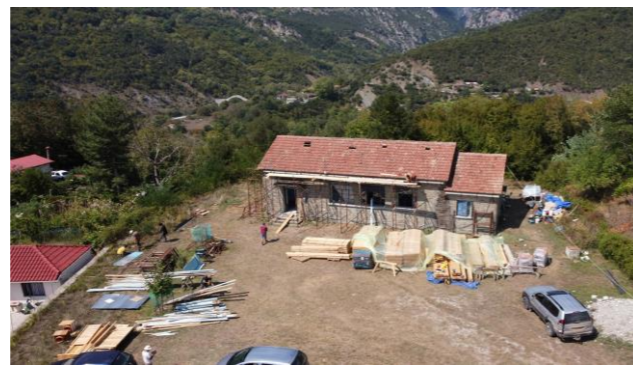
Εικ. 1: Οργάνωση πρώτων υλών στον προαύλιο χώρο του σχολείου – προστασία καινούργιας ξυλείας από την υγρασία (Γ. Κουτρόπουλος)
