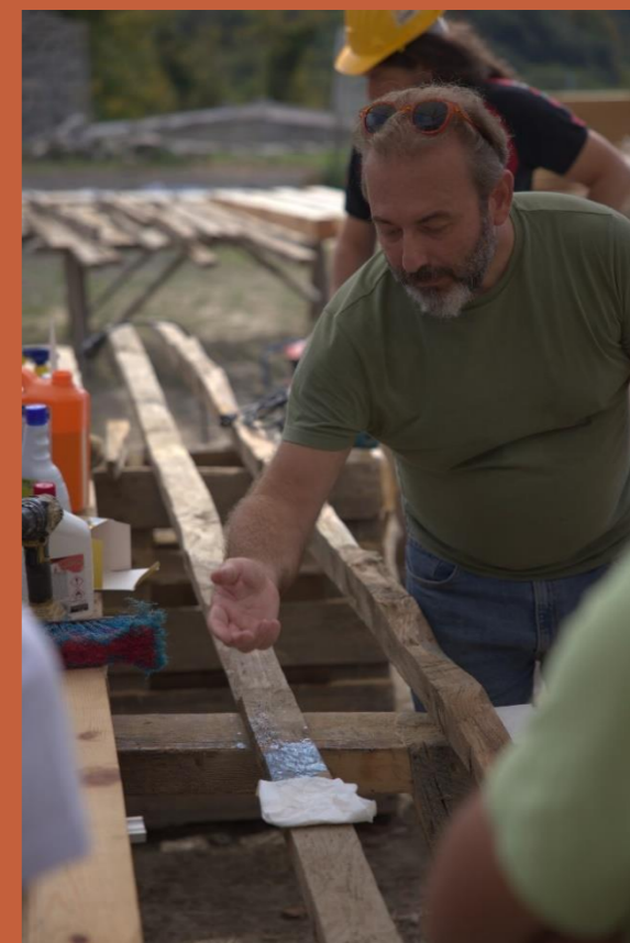
Πάνω: Επίδειξη χρήσης υλικών συντήρησης ξύλου Από τον καθ. Δημήτρη Τσίποτα. (Ι. Αθανασιάδης)
