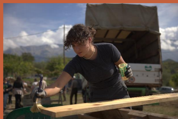
Εικ.4: Βάψιμο σανιδιών πετώματος με λινέλαιο (Ι. Αθανασιάδης)
