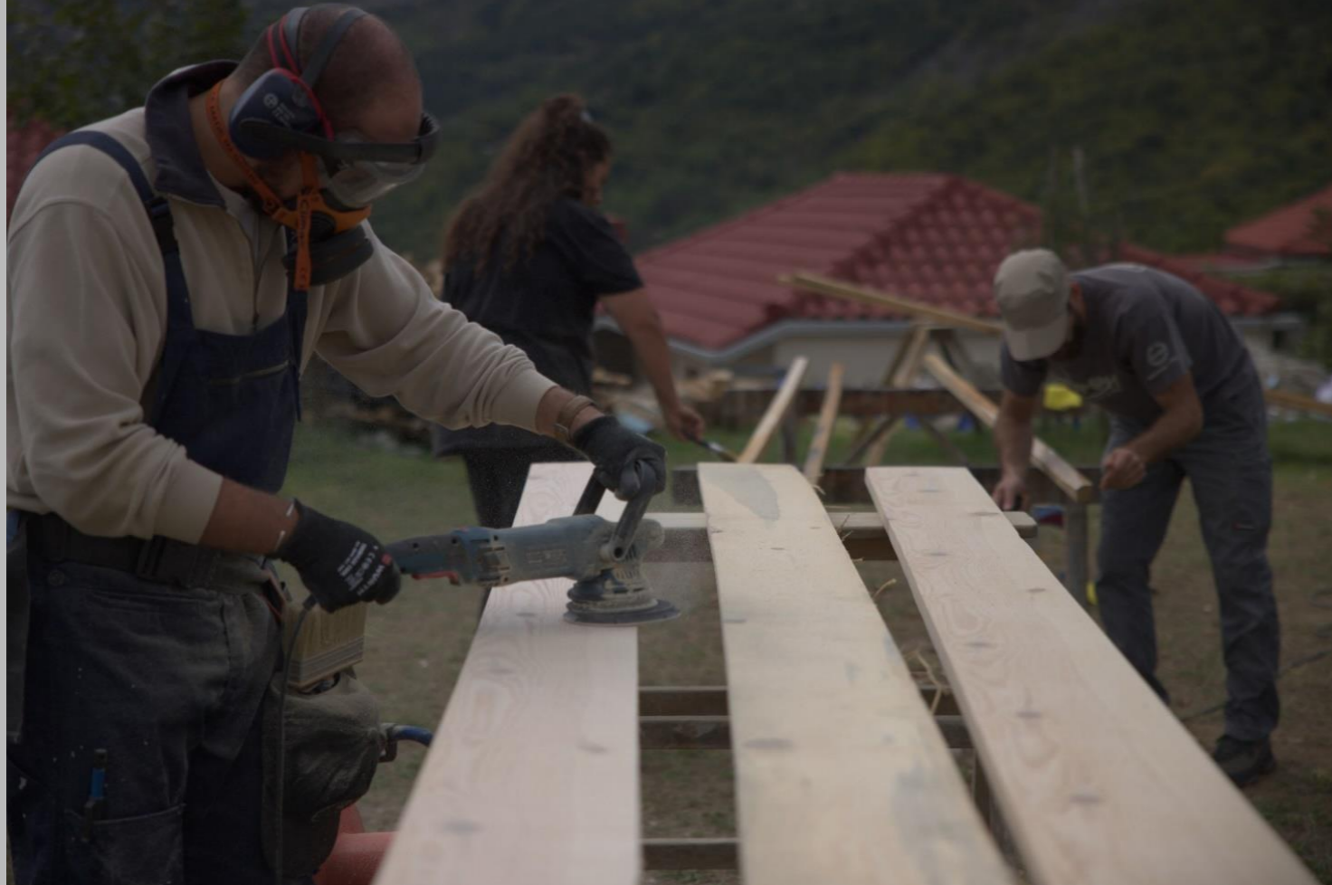
Πάνω: Τρίψιμο σανιδιών και βόψιμο τεγιδών με μείγμα κατραμιού (Ι. Αθανασιάδης)
