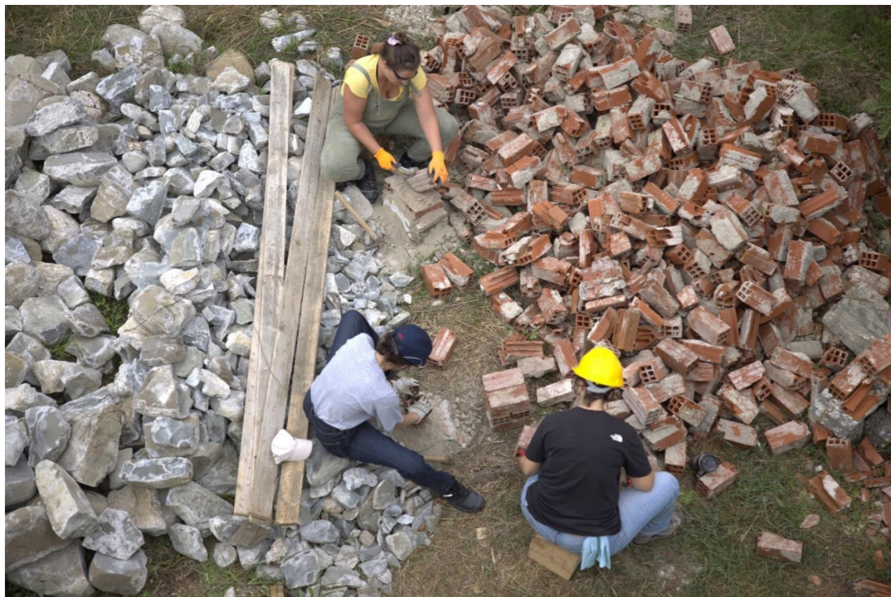
Πάνω: Καθαρισμός τούβλων, οργάνωση υλικών στον προαύλιο χώρο (Ι.Αθανασιάδης)
