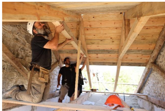
Εικ.40: Εγκοπή στο κύριο δοκάρι για σύνδεση με διαγώνια ενισχυτική δοκό (Ι.Αθανασιάδης)
