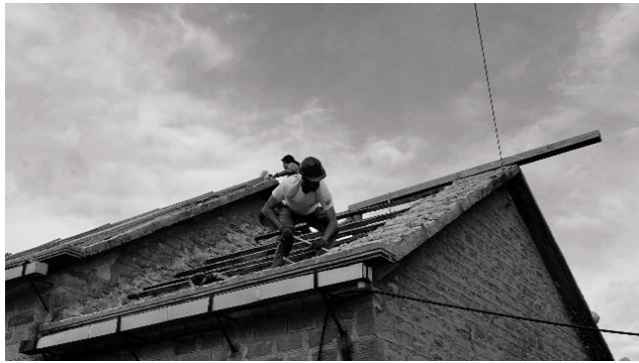
Εικ. 6: Αφαίρεση κεραμιδιών (Χ. Λιόγκας) Εικ. 7: Στίβες με ακέραια κεραμίδια προς επανάχρηση (Ι. Ντούτση) Εικ. 8: Καθαρισμός περιμετρικού σενάζ (Β. Χήτα) Εικ. 9: Αφαίρεση κεραμιδιών και στοιβαγμα στη σκαλωσιά (Χ. Λιόγκας) Απέναντι : Κατέβασμα κεραμιδιών με τροχαλία (Ι. Αθανασιάδης)
