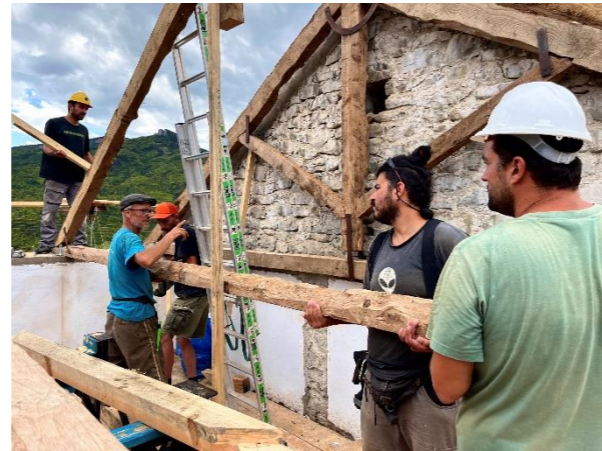
Εικ. 14: Κοπή παλιού ελκυστήρα (Β.Χήτα) Εικ. 15: Κοπή παλιού ελκυστήρα (Β.Χήτα)
