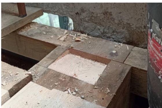
Εικ.21: Εγκοπή στο κύριο δοκάρι για να συνδεθεί η διαγώνια ενισχυτική δοκός (Ο.Αποστολάτος) Εικ.22: Εφαρμογή και αλφάδιασμα διαγώνιας ενισχυτικής δοκού (Ο.Αποστολάτος)
