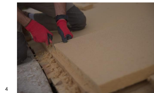
Εικ. 1: Εφαρμογή μαλακού wood fiber στη μεγάλη στέγη (Ι. Αθανασιάδης) Εικ. 2: : Βιδώθηκαν τεγίδες για να εφαρμοστεί το μαλακό wood fiber ανάμεσα (Ι. Αθανασιάδης) Εικ. 3: Εφαρμογή μαλακού wood fiber στη μεγάλη στέγη (Ι. Αθανασιάδης) Εικ. 4: Το μαλακό wood fiber κόβεται με φαλτσέτα στο κατάλληλο μέγεθος για να τοποθετηθεί (Ι. Αθανασιάδης)
