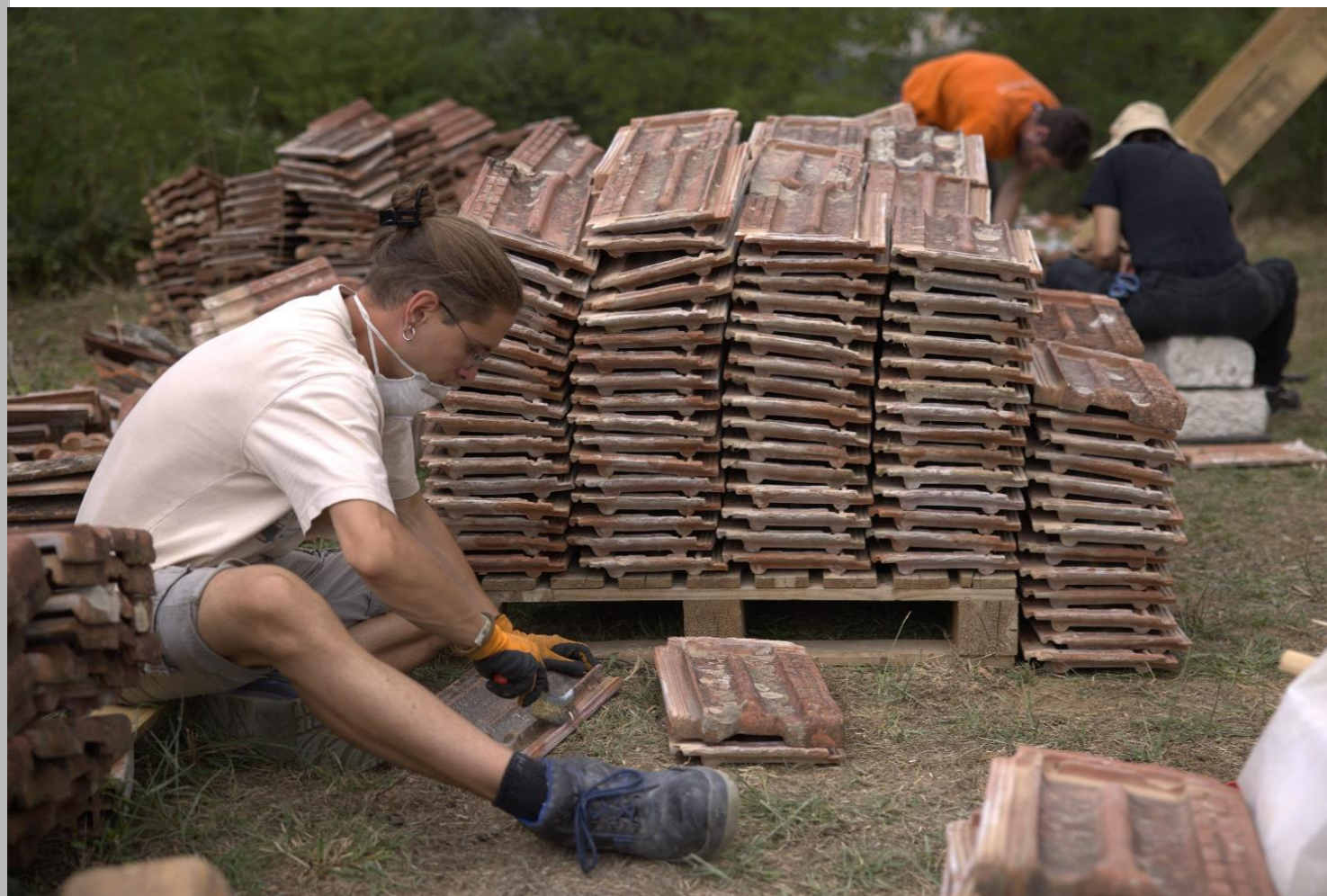
Εικ.7: Καθαρισμός κεραμιδιών και ταξινόμηση (Ι.Αθανασιάδης)
