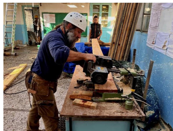
Εικ. 2: Σανίδωμα στέγης. Φαίνεται το σανίδι στο οποίο είχαν σημειωθεί τα μήκη των σανιδιών.
