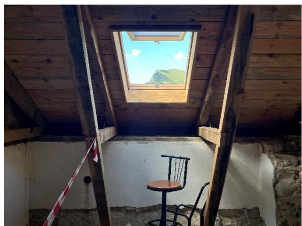
Εικ.13: Τοποθέτηση φεγγίτη (Ο. Αποστολάτος) Εικ.14: Εφαρμογή μαλλιού προβάτου στο κενό (Β. Χήτα) Εικ.15: Τοποθέτηση κάσας φεγγίτη (Ι.Αθανασιάδης) Εικ.16: Ολοκληρωμένος Φεγγίτης (Β.Χήτα) Απέναντι: Ορισμός τοποθέτησης παραθύρου (Ι.Αθανασιάδης)
