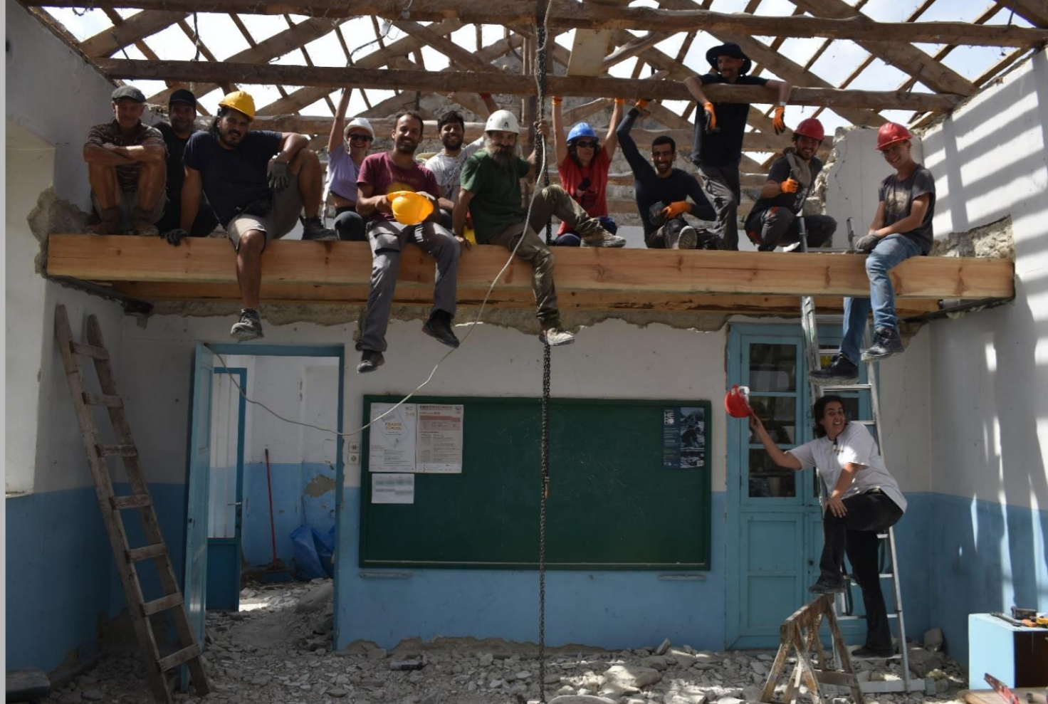
Πάνω: Η ομάδα εργασίας πάνω στο πρώτο δοκάρι του παταριού που τοποθετήθηκε. (Π.Κωστούλας)
