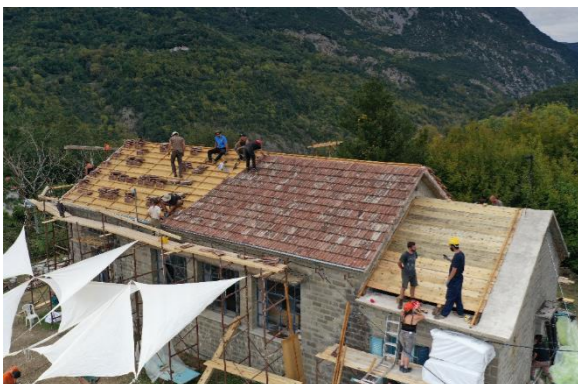
Εικ. 7: Ο τεχνίτης Dominic Taylor στην σκαλωσιά (Ι. Αθανασιάδης) Εικ. 8: Μετά την ολοκλήρωση του σανιδώματος τοποθετούνται οι τεγίδες στην μικρή στέγη (Ι. Αθανασιάδης)
