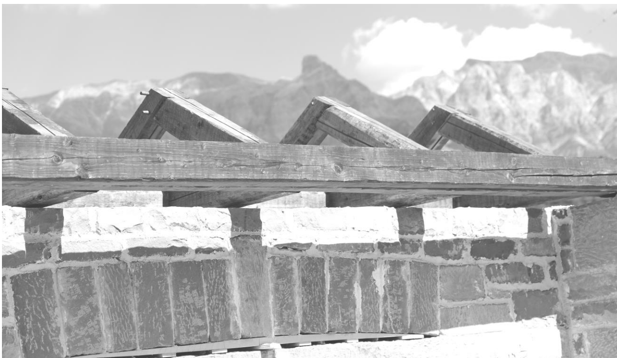
Fig. 10 La charpente en bois d'un portail en maçonnerie de pierre, protégée par du goudron de pin. Atelier de l'école Frasta, 2022 (Archives Boulouki, crédit Ioanna Ntoutsis)
