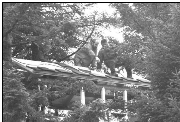
Fig.1 - Utilisation expérimentale de goudron de pin (commercial) pour la protection des tuiles en bois d'une cabane en bois dans le refuge montagneux de Pramanta Atelier "Abris-Deux ateliers en tandem", mai 2019. (Crédits : Boulouki's Archive)
