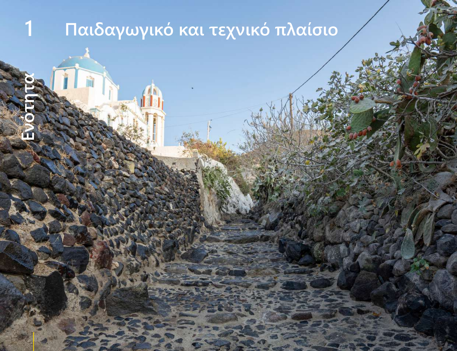
Ξερολιθικό μονοπάτι και πλευρικοί τοίχοι από ηφαιστειακές πέτρες στις Κυκλάδες, Ελλάδα.
