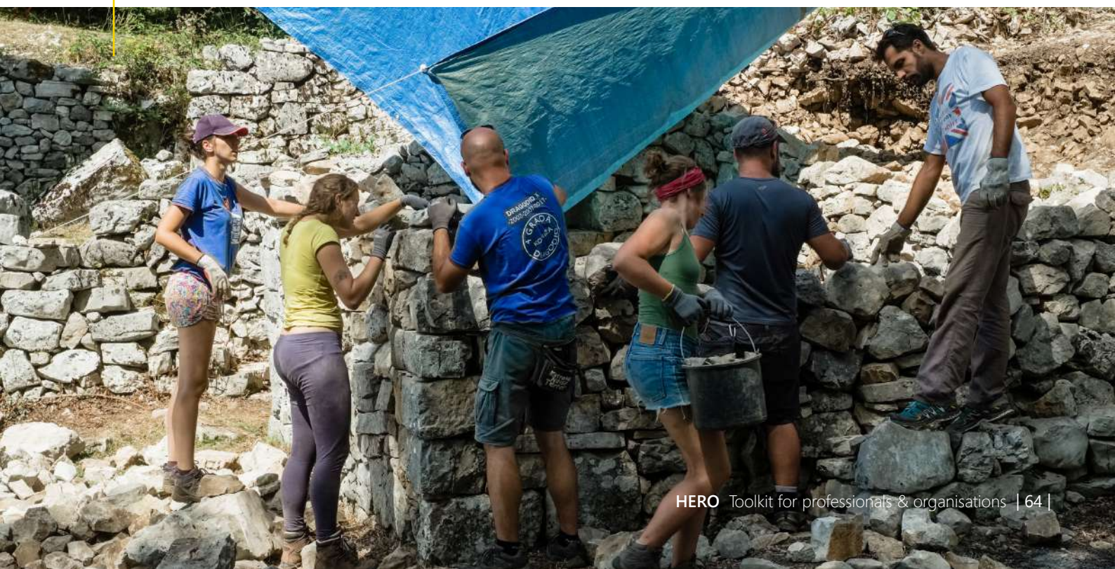
Αποκατάσταση ξερολιθιάς, Petrebišća, βουνό Učka, Κροατία.
