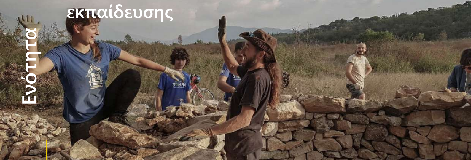
Εκπαιδευτής και εκπαιδευόμενος πανηγυρίζουν για την επιτυχή ολοκλήρωση των εργασιών Konavle, Κροατία.
