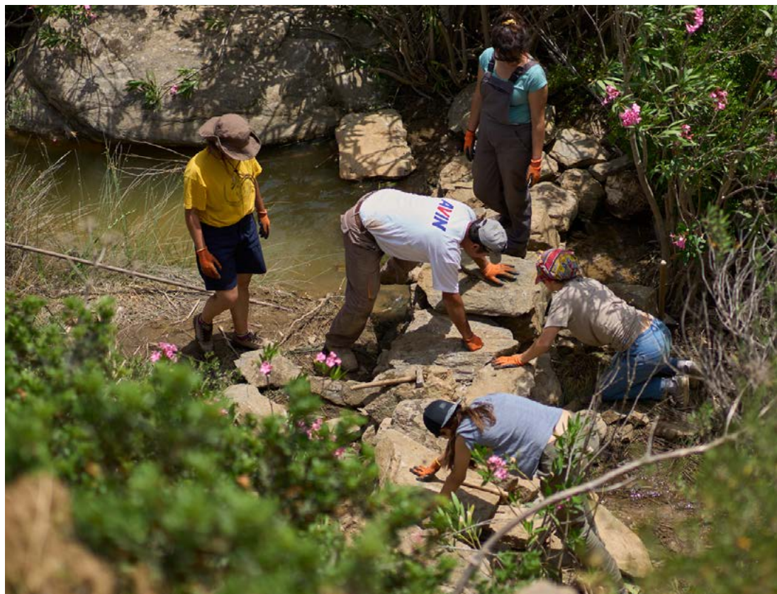
Στιγμιότυπο από το εργαστήριο κατασκευής μικροφραγματων στον Καβουροπόταμο της Πάρου. Φωτ. Κωνσταντίνος Μαύρης
