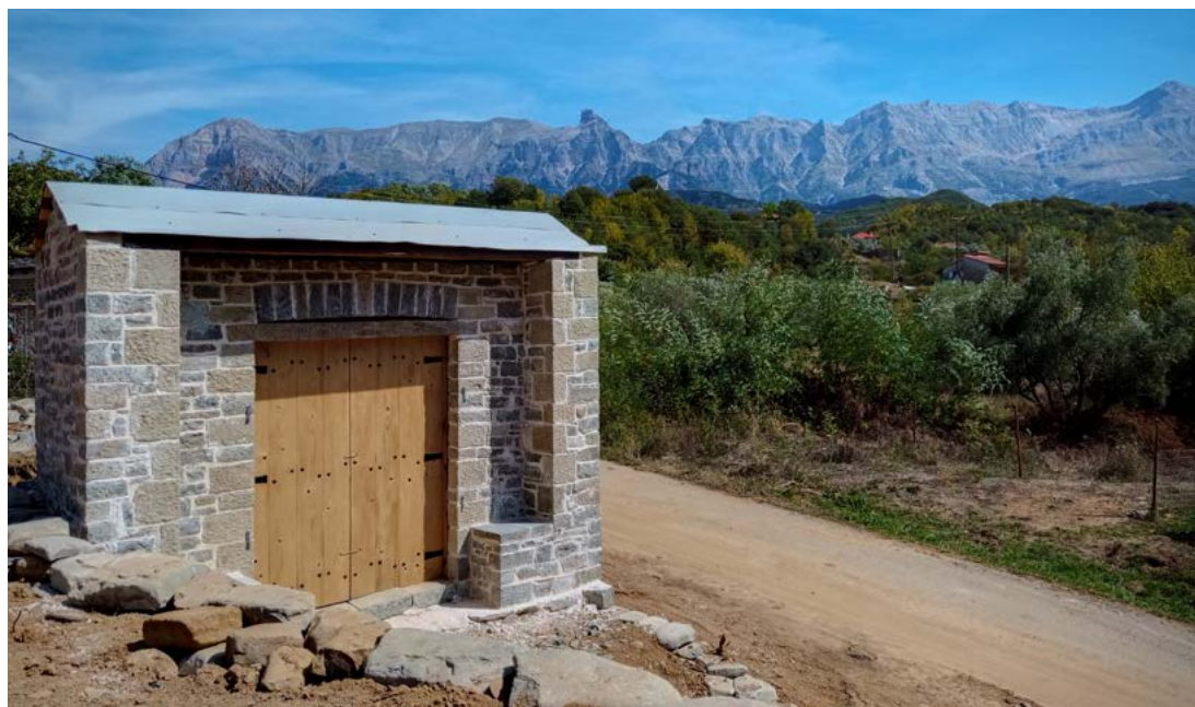
Η νέα αυλόθυρα του δημ. σχολείου Φράστων που κατασκευάστηκε κατά τη διάρκεια του εργαστηρίου Frasta School | Ένα σχολείο για τις παραδοσιακές τεχνικές δόμησης. Φωτ. Γρηγόρης Κουτροπουλος
