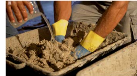
Εικ. 32: Στιμωμένο κατά τη διάρκεια της καθημερινής (έως επί 7 ημερών) ανάμιξης του κονιαματος της τελικής στρώσης, του αλείμματος. (Φωτ. Γ. Κουτσουλάκος)
