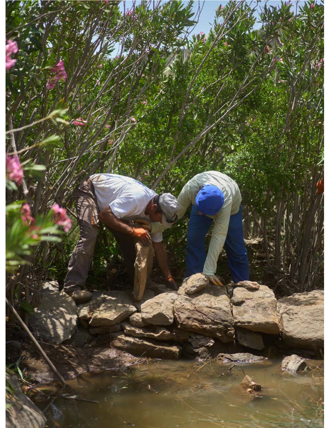
Στιγμιότυπο από τις εργασίες πεδίου κατασκευής μικροφραγματων στον Καβουροπόταμο της Πάρου. Φωτ. Κωνσταντίνος Μαύρης
