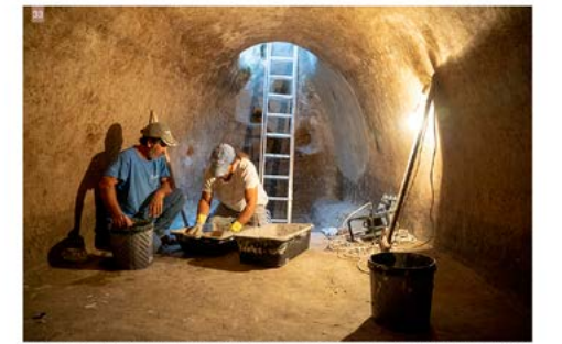
Εικ. 33: Η ανάμιξη και συντήρηση του αλείμματος γίνεται εντός της στέρας, σε συνθήκες υψηλής υγρασίας. (Φωτ. Γ. Κουτσουλάκος)
