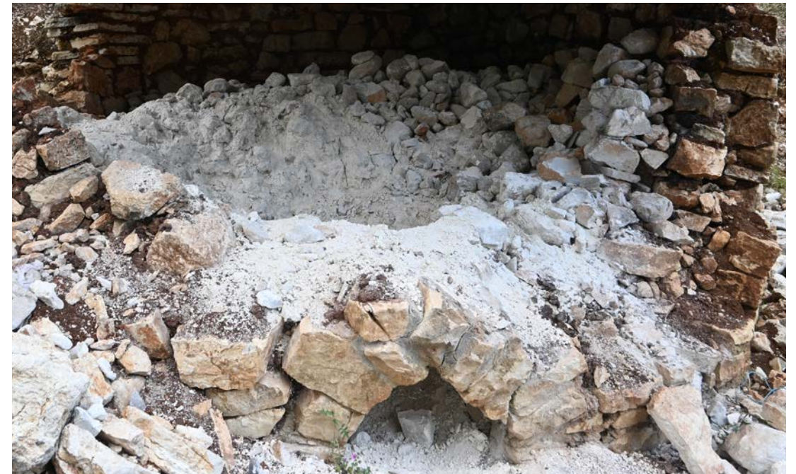
Υπολείμματα ασβεσταριάς κοντά στο Δολό Πωγωνίου στην Ήπειρο, κατασκευή του 2019 από τον μάστορα Γιάννη Λαχανά. Φωτ. Χριστόφορος Θεοχάρης
